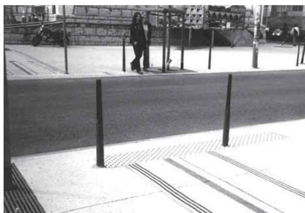
Figure 3 : Aménagement de voirie : bandes d'éveil de vigilance et aide au repérage au droit des traversées piéton (Lyon). Il n'en reste pas moins que la traversée doit aussi être protégée
