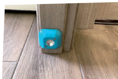
Éclairage rasant avec capteur de mouvement au sol sur le parcours des toilettes de nuit, depuis la chambre.
